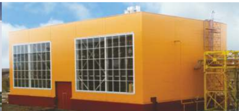
ПАРОВАЯ КОТЕЛНЯ ПАО «КОРПОРАЦИЯ ВСМПО-АВИСМА» Березники, промплощадка «ВСМПО-АВИСМА»
