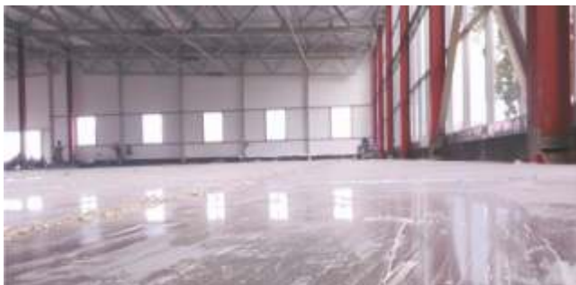
Топпинговые полы. Здание склада ООО «Инкаб»
