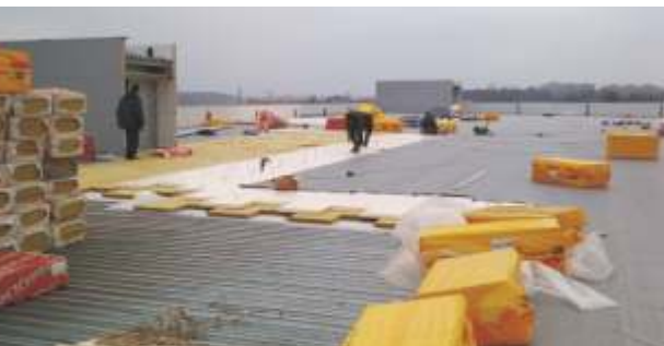
Устройство мембранной кровли. Складской комплекс ЗАО «Фуд-Трейд»
