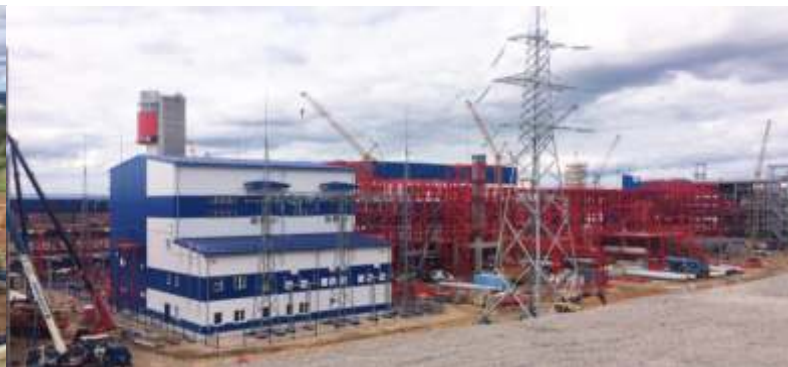
СТРОИТЕЛЬСТВО ПОДСТАНЦИИ 110 КВ. ДЛЯ ПАО «МЕТАФРАКС» Губаха, ПАО «Метафракс»
