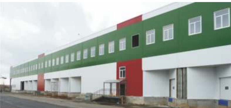
СКЛАДСКОЙ КОМПЛЕКС ЗАО «ФУД ТРЕЙД» г. Пермь, Деревообделочная, 6а
