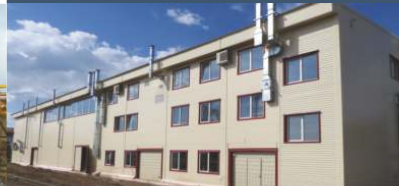
ТЕХНИЧЕСКОЕ ПЕРЕООРУЖЕНИЕ ПРОИЗВОДСТВА ОАО ПИЛОМАТЕРИАЛЫ «КРАСНЫЙ ОКТЯБРЬ» Пермь, ул. 9 Января, 16
