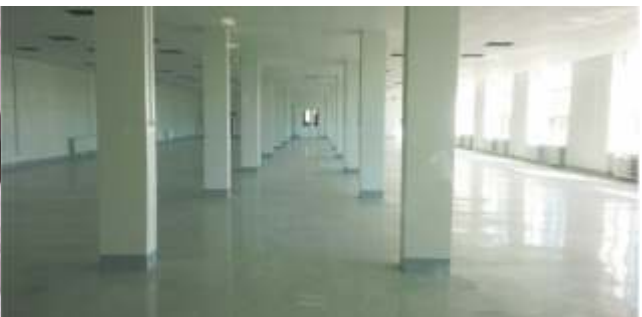
Полимерные полы. Производственный цех ОАО «Пермская Научно-Производственная Приборостроительная Компания»
