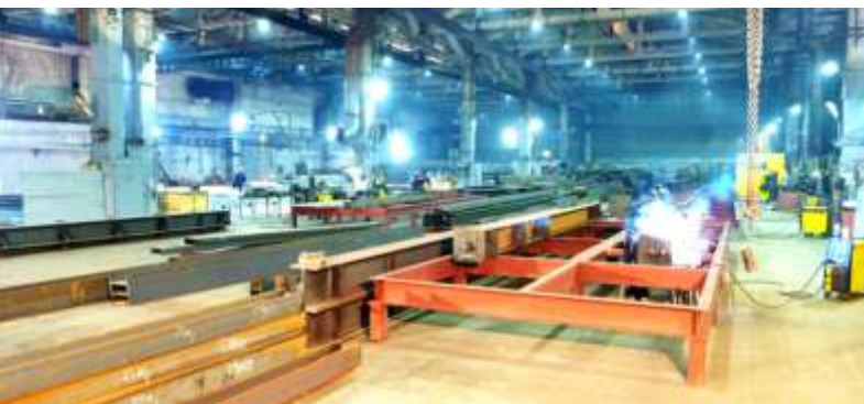
УЧАСТОК СБОРКИ/СВАРКИ МЕТАЛЛОКОНСТРУКЦИЙ
