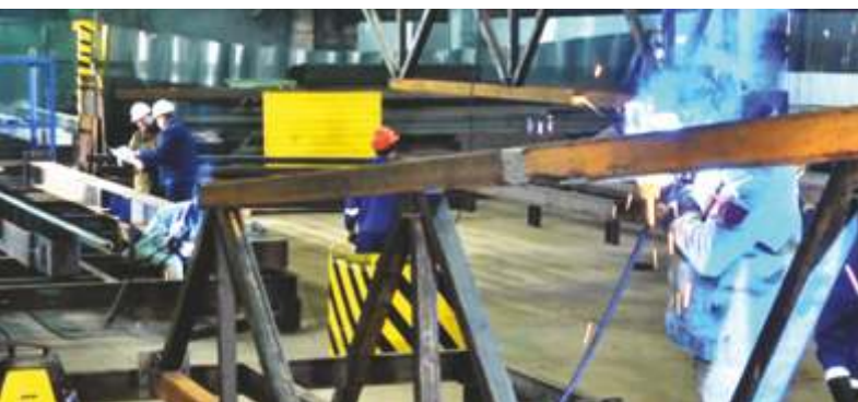
УЧАСТОК СБОРКИ/СВАРКИ МЕТАЛЛОКОНСТРУКЦИЙ
