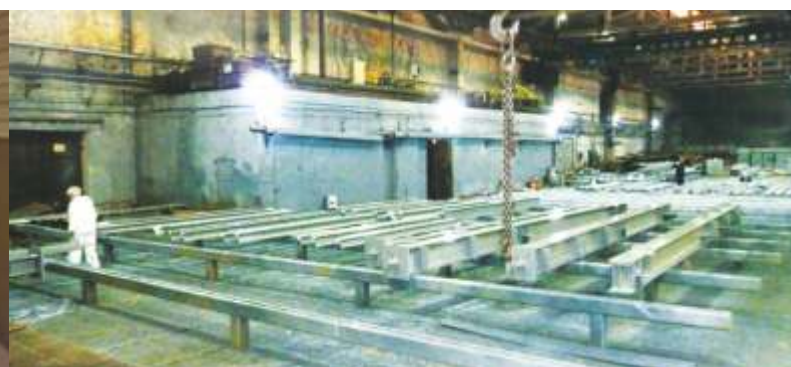
УЧАСТОК АНТИКОРРОЗИЙНОЙ ОБРАБОТКИ И ОКРАСКИ МЕТАЛЛОКОНСТРУКЦИЙ
