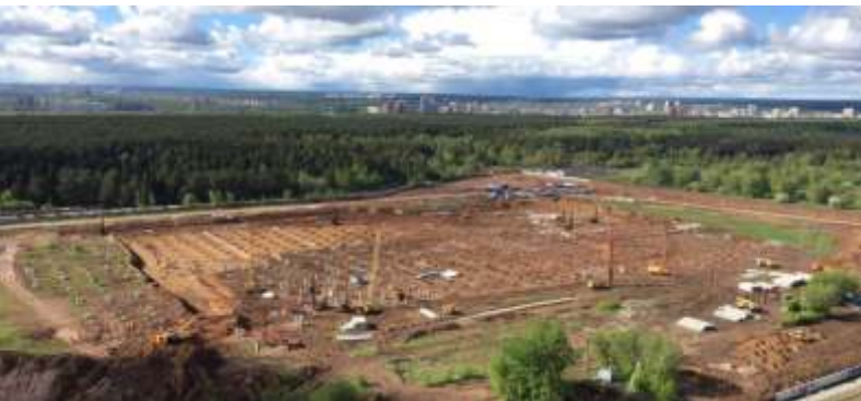
ТОРГОВО-РАЗВЛЕКАТЕЛЬНЫЙ ЦЕНТР ПО УЛ. ШОССЕ КОСМОНАВТОВ ТРЦ «Планета»
