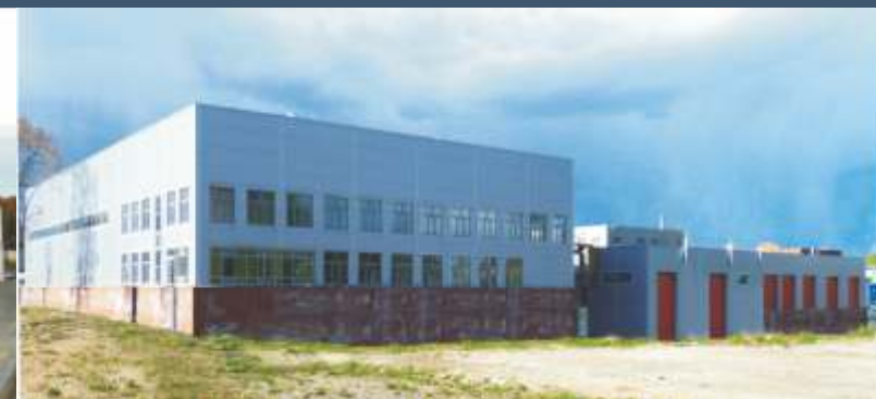
АДМИНИСТРАТИВНО-СКЛАДСКОЙ КОМПЛЕКС «ПРОМЭЛЕКТРОСЕРВИС» Пермь, ул. Ижевская, 2
