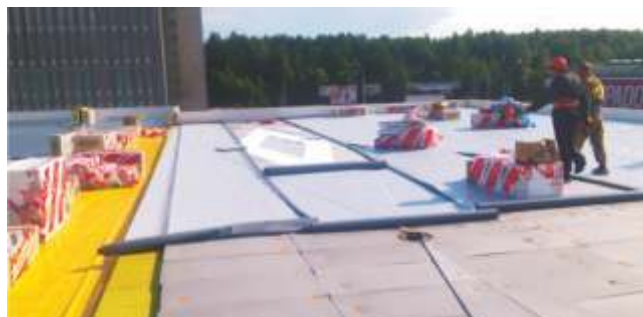
Устройство мембранной кровли. Гипермаркет «Виват» ООО «Виват-Трейд»
